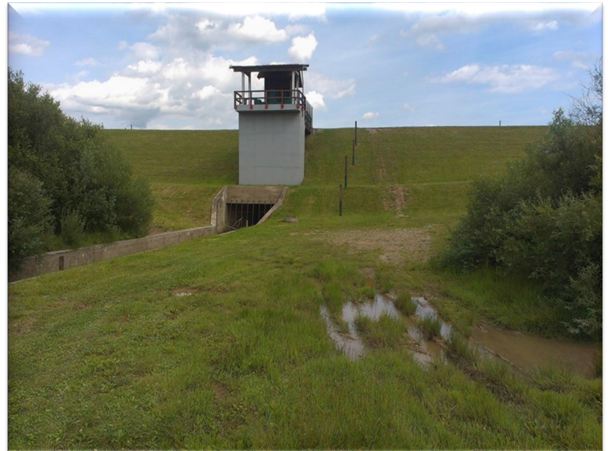
Pogled dolvodno na vtočni objekt z rešetko in hišico za upravljanje.
