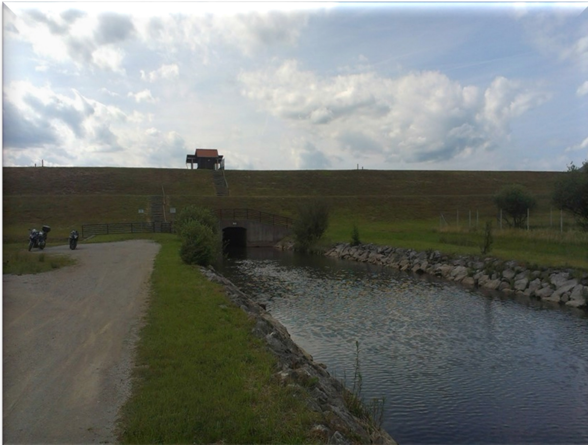
Pregrada Prigorica pri Ribnici – pogled na iztočni del, spodnja stran pregrade.
