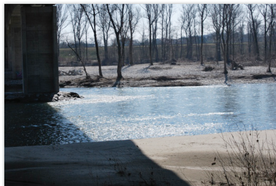
Razširitev s plitvim nabrežjem in redko zarastjo / Aufweitungsbereich mit flachen Ufern zur Auwaldentwicklung
